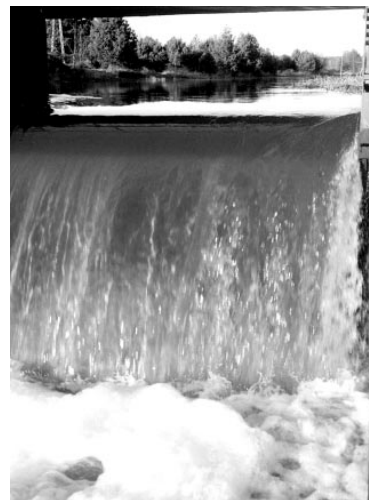
Fragment jazu Sułów na którym powstaje mała elektrownia wodna. Fot. WR
