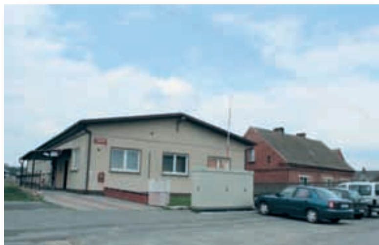
Ryc. 5.115. Wiejski Dom Kultury we Wszewilkach. Nowa forma obiektu. Brak elementów nawiązujących do specyfiki regionu.
