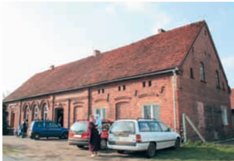
Ryc. 5.113. Dawny dom ludowy we wsi Brzostowo. Dziś sklep z kawiarnią. Wymieniono okna zmieniając charakter elewacji.
