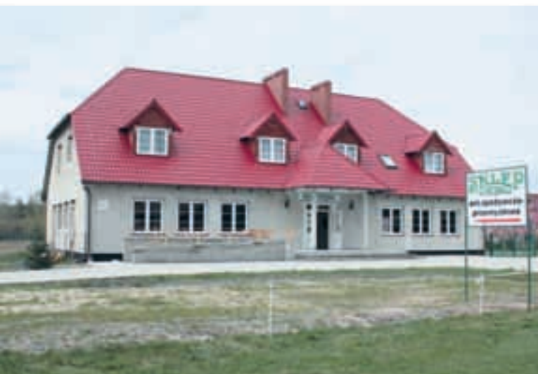
Ryc. 5.126. Gruszcza. Sklep wiejski, pozytywny przykład nowej zabudowy.
