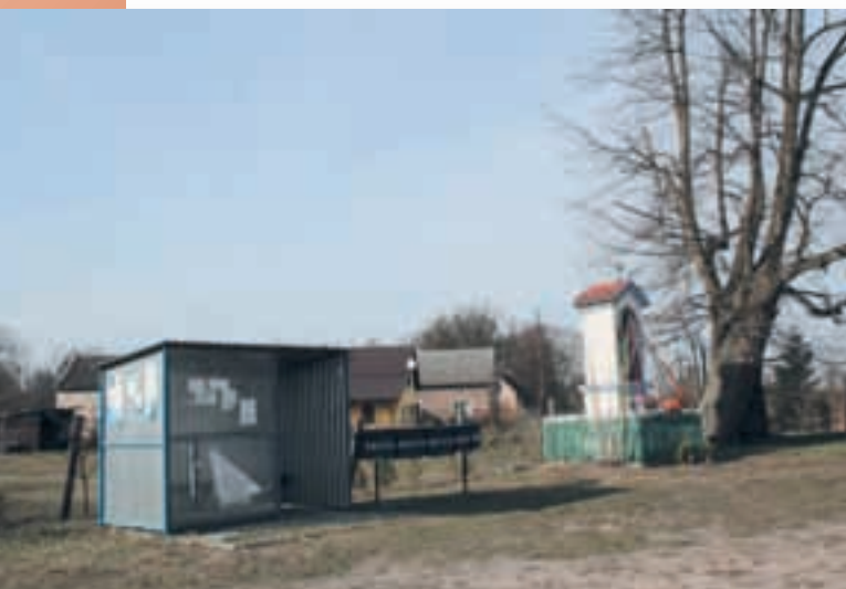
Ryc. 5.188. Ruda Żmigrodzka. Prowizoryczna wiata przystankowa na tle kapliczki.
