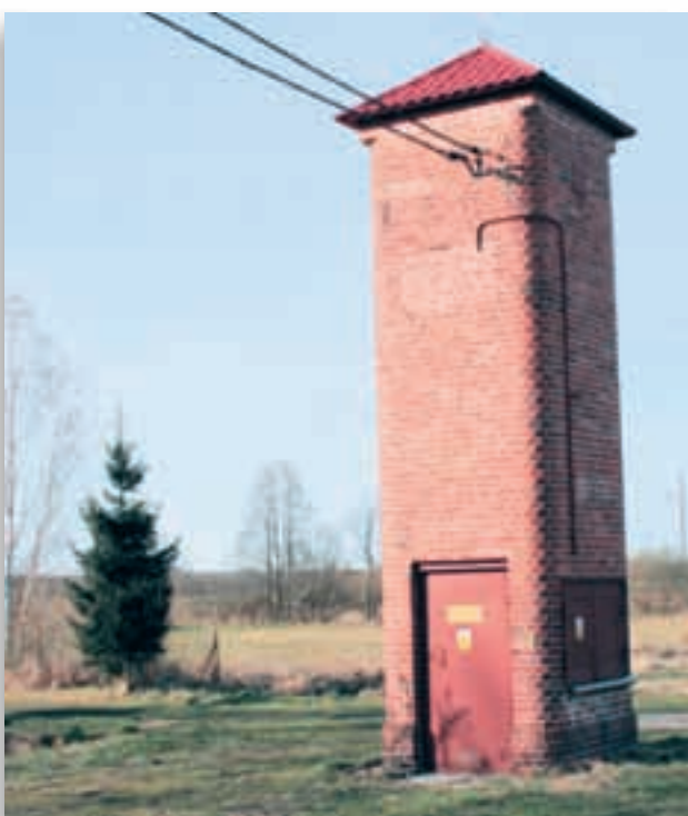
Ryc. 5.157. Trafostacja wieżowa w Niezgodzie. Najczęściej występujący model, z zaokrąglonymi narożami.
