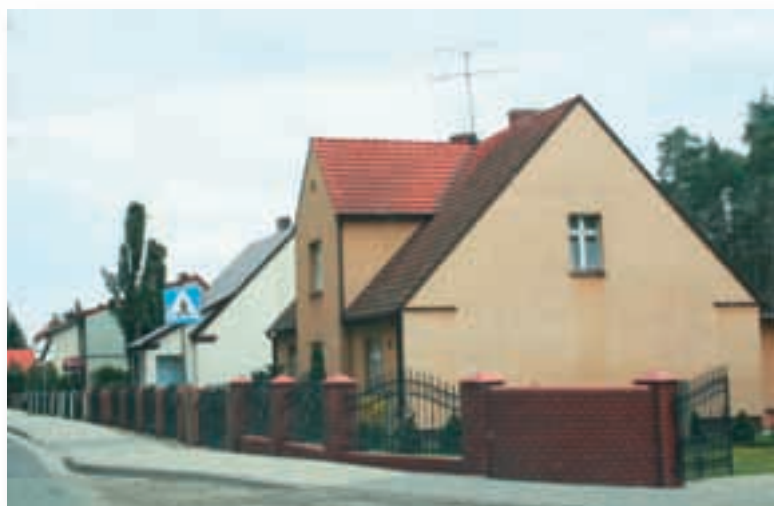
Ryc. 5.44. Krośnice. W budynku na pierwszym planie niepotrzebnie część gzymsu pomalowano w kolorze elewacji, przez co stał się optycznie zbyt cienki. Gzyms domu w głębi korzystnie powtórzono na nowej dobudówce.
