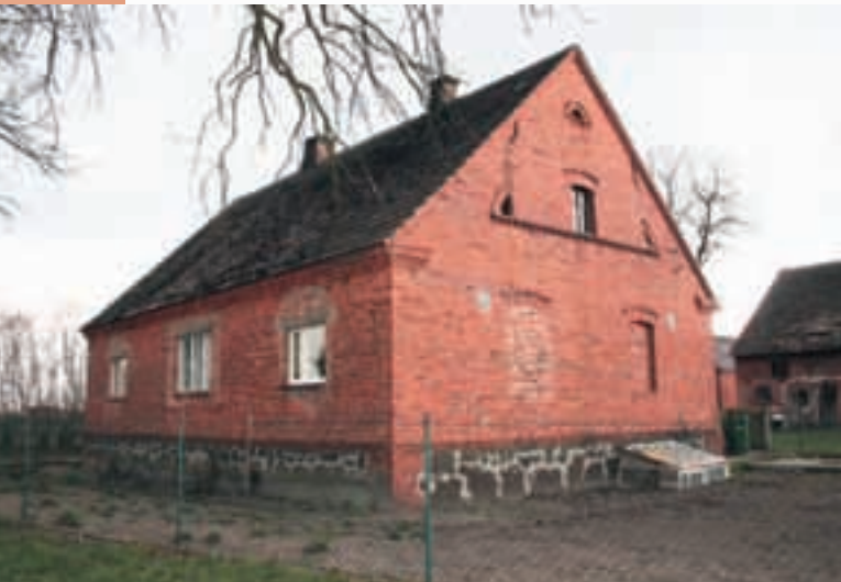
Ryc. 5.3. Czeszyce. Ściany budynku wykonano z cegły licówki, cokół z brył rudy darniowej.
