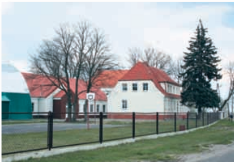
Ryc. 5.95. Gimnazjum we Wróblińcu. Przykład rozbudowy i przystosowania dawnej szkoły do współczesnych wymogów z zachowaniem charakteru dawnej zabudowy.
