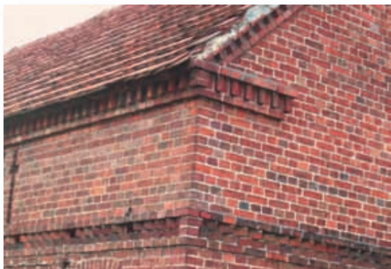
Ryc. 5.34. Jednakowy detal miały wszystkie budynki w zagrodzie. Budynek inwentarski w tradycyjnej zagrodzie w Henrykowicach.
