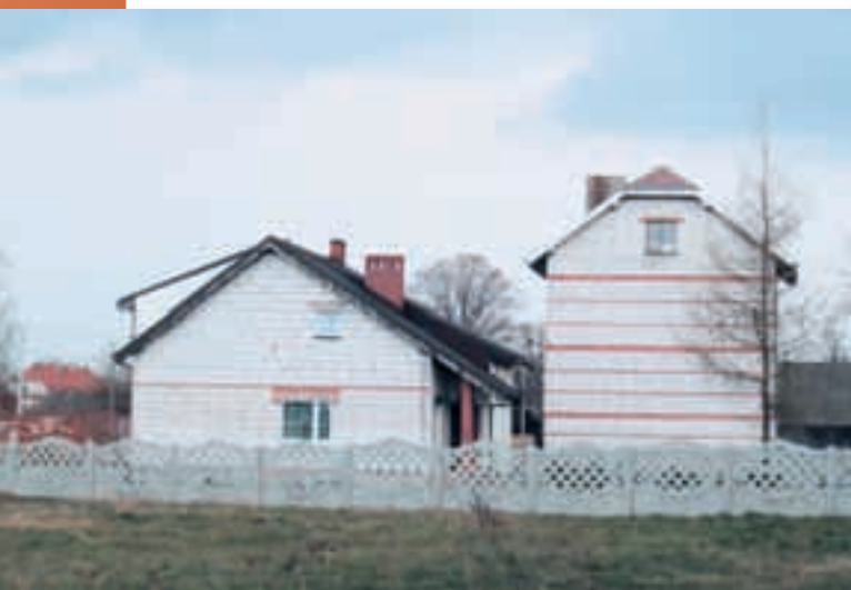
Ryc. 5.66. Kuźnica Czeszycka. Wielość kondygnacji, przypadkowa asymetria ściany szczytowej, różne dachy – tak powstaje chaos w przestrzeni.
