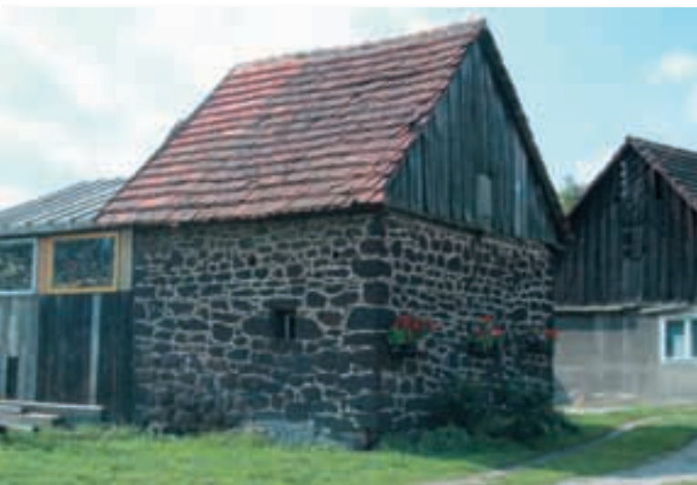
Ryc. 5.77. Ruda darniowa stosowana do budowy ścian jest elementem wyróżniającym budownictwo w rejonie Doliny Baryczy.
