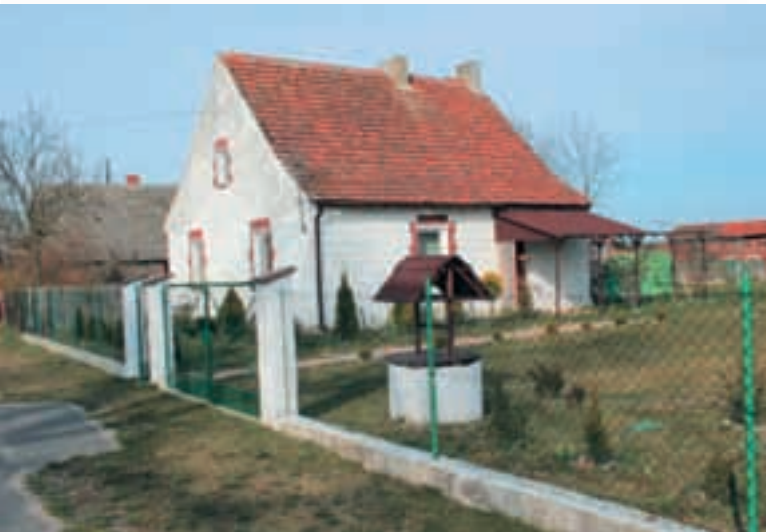
Ryc. 5.9. Ruda Żmigrodzka. Ściana z pustaków żwirowo-ce- mentowych, popularna w latach trzydziestych i czterdziestych ubiegłego wieku.
