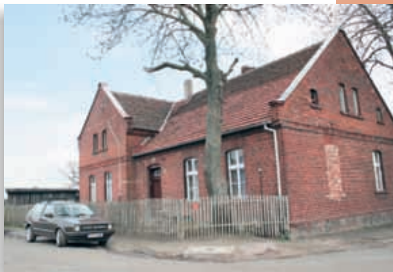
Ryc. 5.107. Dawny dom ludowy zlokalizowany w centralnej części wsi Bartniki. Dziś budynek mieszkalny.
