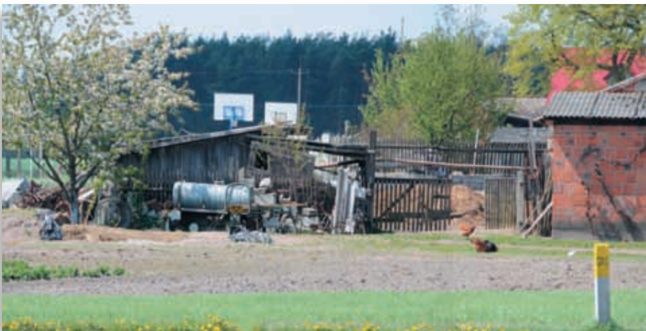
Ryc. 2.4. Zagroda wymagająca natychmiastowej modernizacji.
