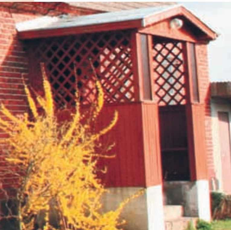
Ryc. 5.42. Forma i kolor współczesnego ganku, dobrze koresponduje z architekturą obiektu, mimo że z trudem mieści się on pod okapem domu.
