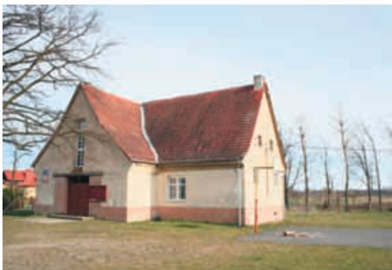
Ryc. 5.97. Radziądz. Budynek dawnej szkoły, dziś świetlica.
