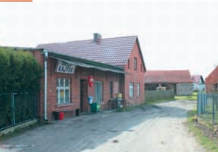
Ryc. 5.122. Radziądz. Sklep w dobudówce dopasowanej materiałem do budynku mieszkalnego.
