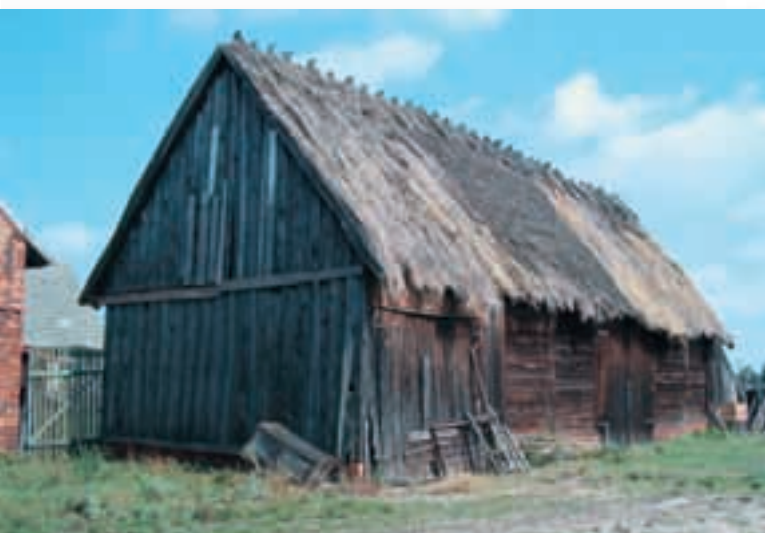
Ryc. 5.79. Dach kryty strzechą w stodole z miejscowości Grabownica.
