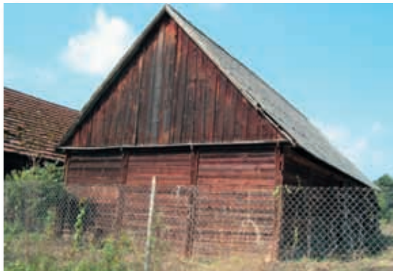
Ryc. 5.74. Ściany stodoły o konstrukcji sumikowo-łatkowej.
