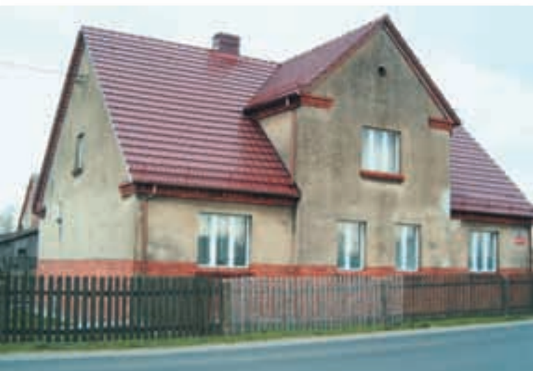
Ryc. 5.20. Czarnogołdź. Osioły ryzalit przechodzący w lukarnę spotyka się również w budynkach o elewacjach tynkowanych. Bardzo wysoki cokół z licówki w tym przypadku zmienia optycznie proporcje elewacji.
