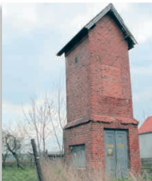
Ryc. 5.158. Chatkowice. Trafostacja wieżowa z podziałem na dwie części, oddzielone gzymsem z dachówki.
