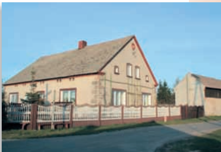
Ryc. 5.23. Sulmierz. Kształt takich tynkowanych budynków nie różni się od tych z elewacją licowaną cegłą. Oryginalny detale ceramiczne i boniowane naroża wzbogacono nieco dyskusyjnym malowaniem opasek okiennych (bez wyraźnej różnicy w grubości tynku).
