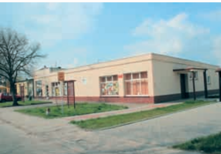
Ryc. 5.117. Gądkowice, świetlica wiejska. Dobra lokalizacja w centrum miejscowości. Bryła niedopasowana do tradycyjnego charakteru wsi w Dolinie Baryczy.
