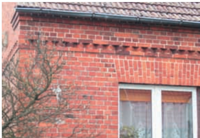
Ryc. 5.57. Ceglane nadproża w formie łuku prostego wraz z fryzami i gzymsami współtworzą architektoniczny charakter domów.
