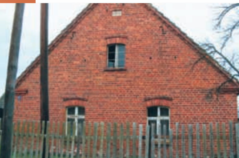
Ryc. 5.16. Żeleźniki. Zachowana jest pełna symetria, zastosowano dekoracyjne nadproża łukowe z okapnikami. U zwieńczenia szczytu zamiast bogatej rozety jedynie otynkowany plafonik z datą powstania budynku.
