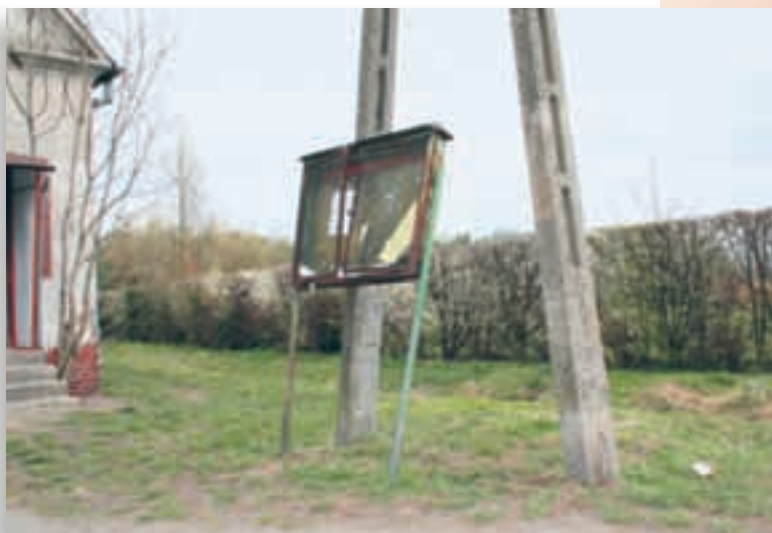
Ryc. 5.207. Luboradów. Metalowa tablica ogłoszeń w złym stanie technicznym.
