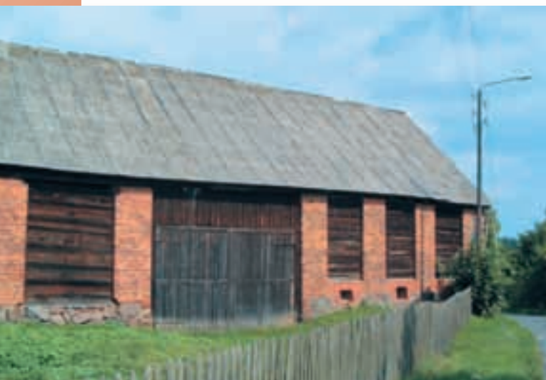
Ryc. 5.72. Szkieletowa, mieszana konstrukcja ścian stodoły.
