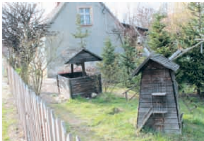
Ryc. 5.215. Wielgie Milickie. Drewniane wykończenie studni.
