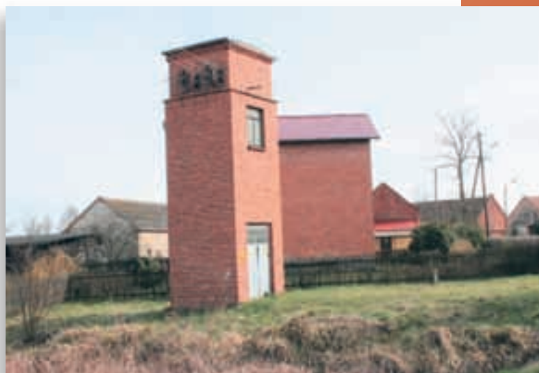
Ryc. 5.160. Radziądz. Dwudzielna trafostacja wieżowa z ozdobnym gzymsem podokapowym.
