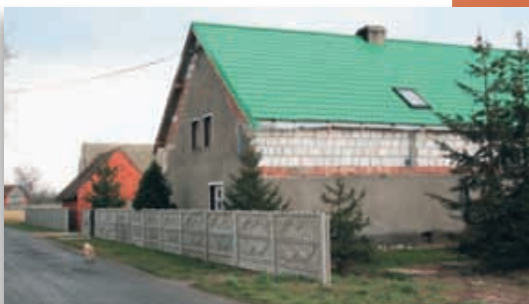
Ryc. 5.51. Wykonanie ścianki kolankowej z pewnością poprawiło możliwości wykorzystania poddasza. Ale dlaczego taki nienaturalny kolor pokrycia z blachy dachówko podobnej, co z usuniętym, tradycyjnym detalem? Dlaczego świerki, dlaczego taki betonowy płot? W oddali piękne, tradycyjne w formie i kolorystyce budynki gospodarcze.
