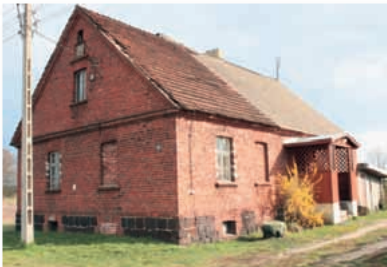
Ryc. 5.18. Wielgie Milickie. Gzyms okapowy przechodzi w poprzek całej elewacji szczytowej. Dobrze jest wkomponowany, drewniany ganek wejściowy.
