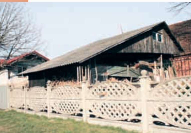
Ryc. 5.195. Kontrast betonu z drewnem.
