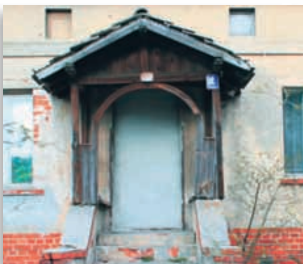
Ryc. 5.41. Drewniany, oryginalny ganek wejściowy do budynku w Henrykowicach. Istniejąca tu ściana kolankowa umożliwiła jego właściwe wkomponowanie.
