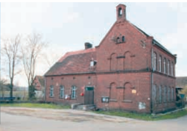
Ryc. 5.108. Henrykowie. Świetlica wiejska ze sklepem.
