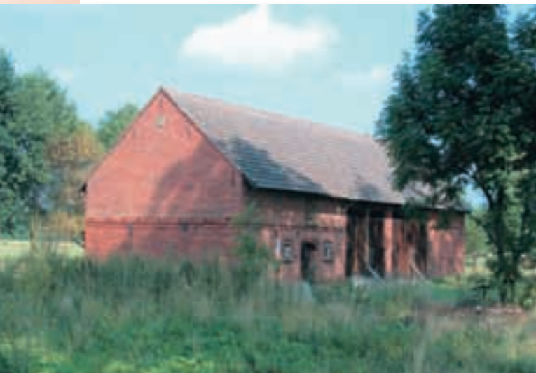
Ryc. 5.71. Stodoła o ścianach z cegły licówki.
