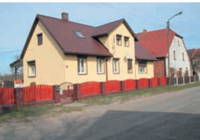
Ryc. 5.47. Borek. Do pełni szczęścia brakuje jednak tych charakterystycznych, zawiniętych na ściany szczytowe podkapowych gzymsów ceramicznych.
