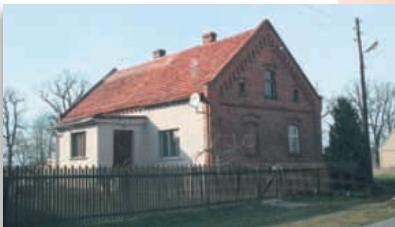
Ryc. 5.49. Ruda Żmigrodzka. Nastąpiła tu modernizacja strefy wejściowej i prawdopodobnie ocieplenie ścian podłużnych wraz z zasługującą na największe uznanie decyzją o zachowaniu bogatego, XIX-wiecznego wystroju ściany szczytowej i ceramicznego gzymsu okapowego. Marzy się jeszcze właściwe dobranie koloru dla otynkowanej ściany i przykrycie dobudówki dwuspadowym dachem.
