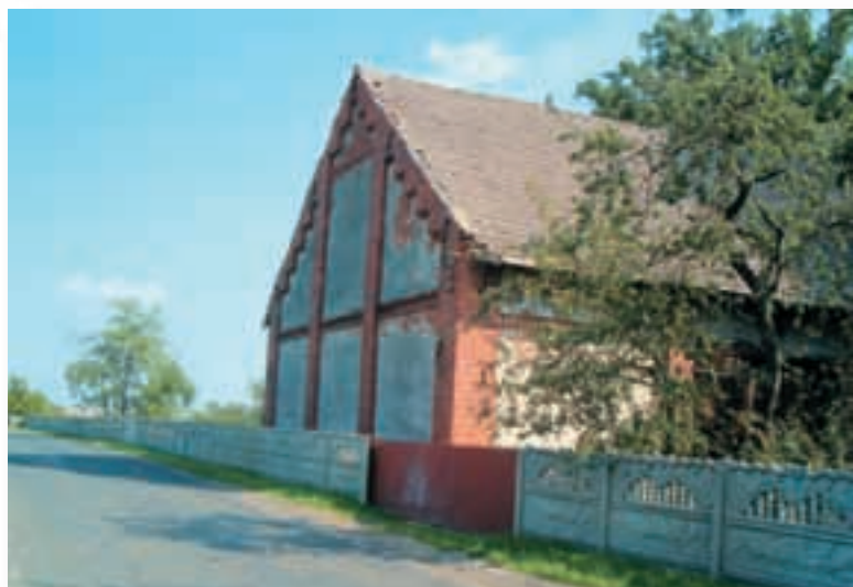
Ryc. 5.75. Ściany stodoły murowane i tynkowane, z detalem architektonicznym.
