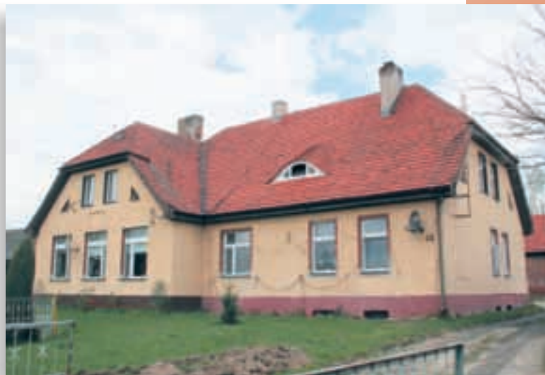
Ryc. 5.100. Wszewilki. Dawna szkoła, dziś budynek mieszkalny. Zmiana podziału okien zakłóca pierwotną harmonię elewacji.
