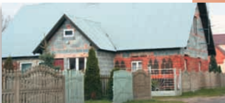
Ryc. 5.50. Klinkierowa licówka z aplikacjami rudy darniowej – wprost esencja miejscowego stylu architektonicznego. Teraz „wzbogaca” ją pustak żużlowo-betonowy, przypadkowa stolarka okienna oraz zbyt wysunięta (w stylu podgórskim) połać dachu, kryta przemysłową blachą falistą. Całość dopełnia betonowo-stalowo-drewniane ogrodzenie. Tak wygląda kontynuacja tradycji kulturowej. Kiedyś tynk, być może ukryje pustaki. Ale czy jedynie pustaki, czy również rudę darniową i klinkierowy detal?
