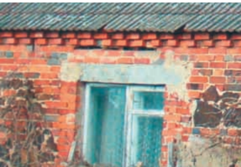
Ryc. 5.58. Nadprożom zagrażają takie wymiany.
