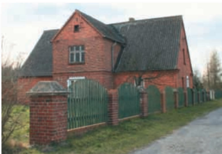
Ryc. 5.19. Wielgie Milickie. Ryzalit na elewacji podłużnej łączy się z dużą lukarną. Pozwala ona na ekonomiczne wykorzystanie powierzchni poddasza.
