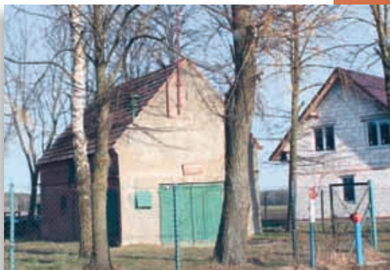
Ryc. 5.150. Olsza. Zadbane budynki remizy strażackiej.
