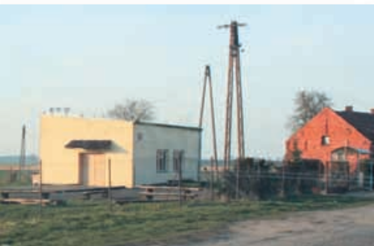
Ryc. 5.118. Węgrzynów. Otynkowana świetlica wiejska z płaskim dachem nie nawiązuje do stojącego obok budynku licowanego cegłą.
