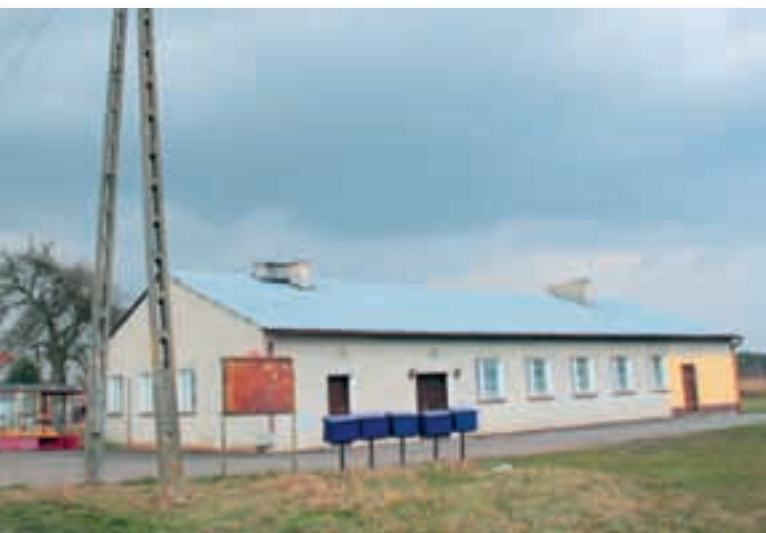
Ryc. 5.116. Kotlarka, współczesny budynek świetlicy. Kolorystyka dachu nie nawiązuje do tradycji regionu.
