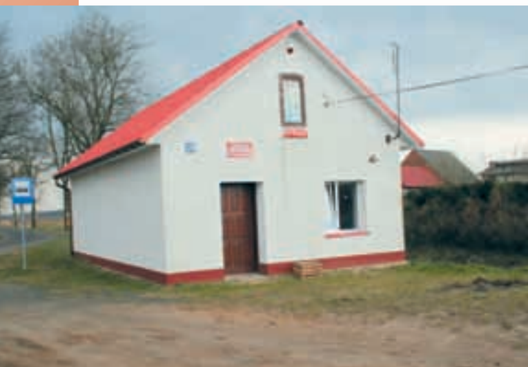
Ryc. 5.153. Kuźnia Czeszycka. Remiza po remoncie.
