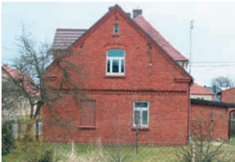
Ryc. 5.17. Krośnice. Sąsiadują ze sobą nadproże łukowe i nadproża o łuku prostym, oddzielone bardzo dekoracyjnym fryzem stropowym.
