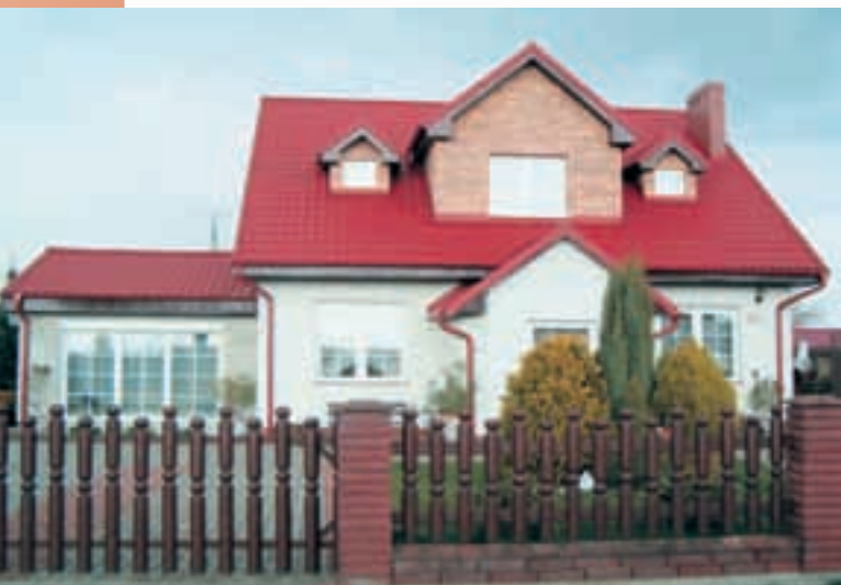
Ryc. 5.65. Czeszyce. Trzy identyczne w formie, a różne w skali lukarny oraz zbyt duże okna w stosunku do powierzchni ściany. Ale jest to i tak jedno z najlepszych współczesnych rozwiązań, odpowiadające tutejszej tradycji.
