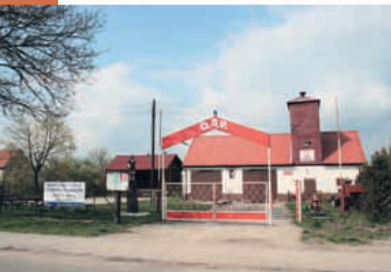
Ryc. 5.155. Gądkowice. Remiza jako jeden z elementów centrum rekreacyjno-usługowego we wsi.
