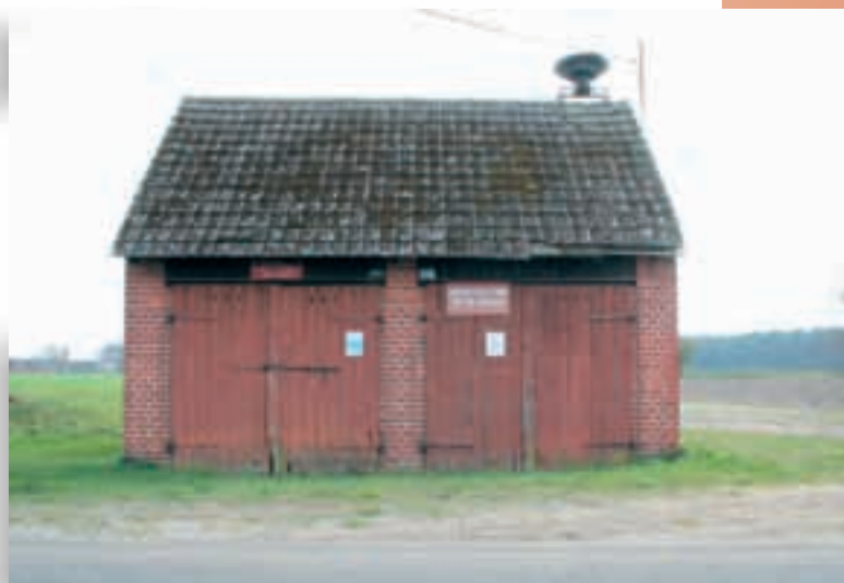
Ryc. 5.148. Wielgie Milickie. Remiza strażacka licowana cegłą.
