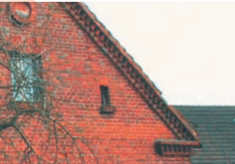
Ryc. 5.30. Charakterystycznie zawinięty na ścianę szczytową gzyms okapowy, w tym przykładzie bardzo przestrzenny.
