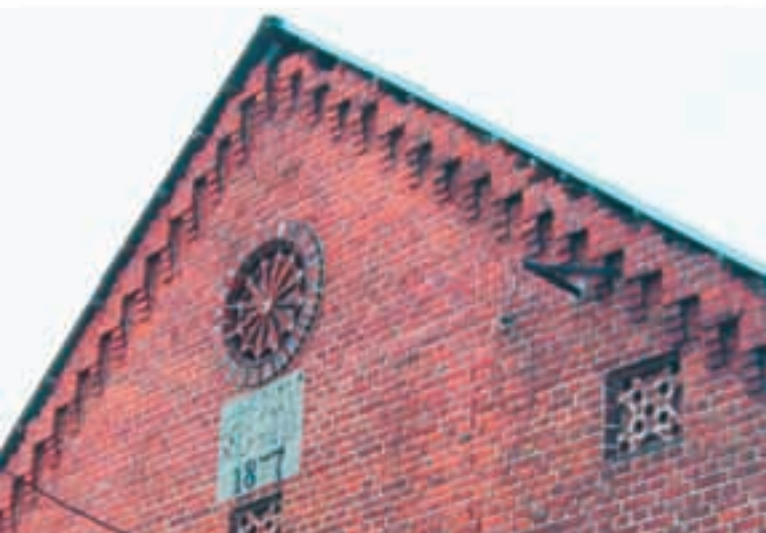
Ryc. 5.36. Przykładowe formy bogatej, XIX-wiecznej ceramiki elewacyjnej.
