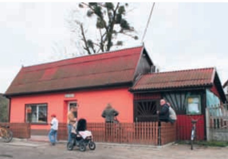
Ryc. 5.128. Czatkowice. Zbyt agresywny kolor elewacji, ale forma obiektu nawiązująca do wsi.
