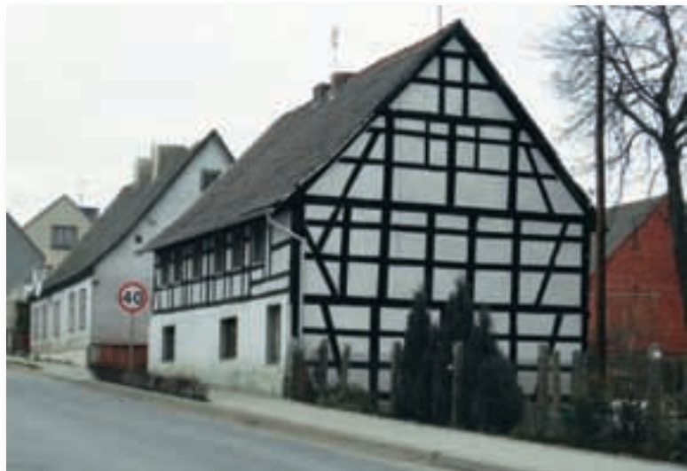
Ryc. 5.5. Ściana o konstrukcji szachulcowej zawsze zwraca uwagę, a sprawia to jej wręcz graficzny charakter, odmienny od otaczającej zabudowy.
