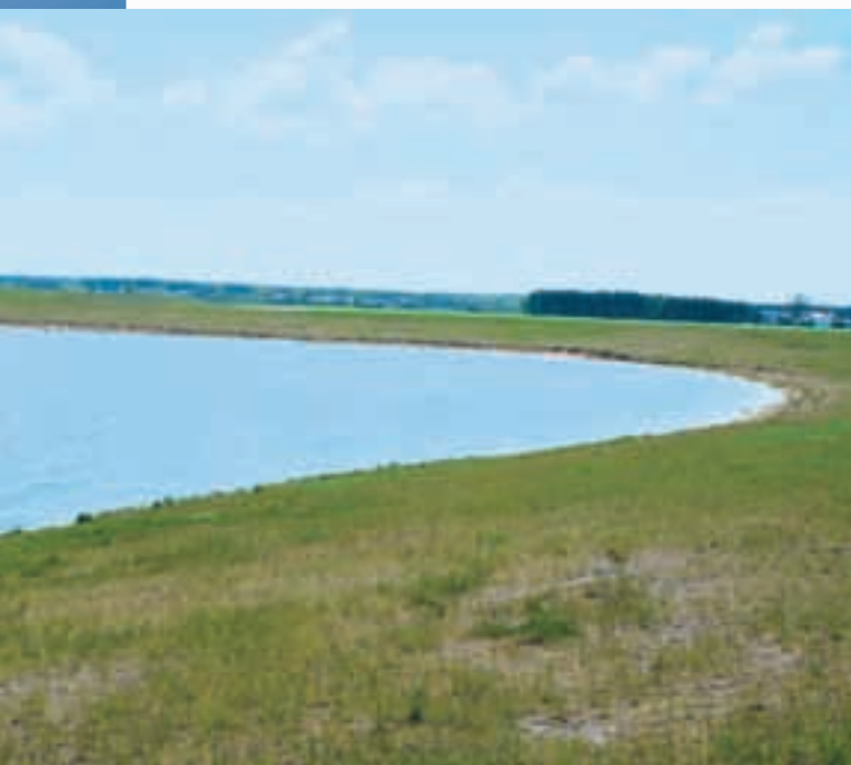
Ryc. 3.9. Nowowyprowadzony zbiornik retencyjny w Pakoście. Falująca woda rozpoczyna erozyjne niszczenie słabo zabezpieczonych brzegów. Zjawisko takie nazywa się abrazją zbiornikową.
