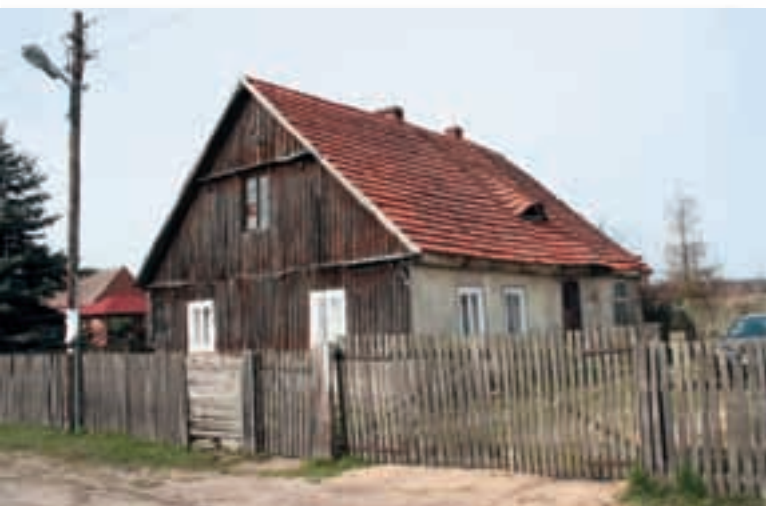
Ryc. 5.10. Borek. Poza pionowym deskowaniem całej ściany szczytowej warto zwrócić uwagę na „wole oko” w połaci da- chowej, doświetlające poddasze. Ten malowniczy element nie występuje tu często.
