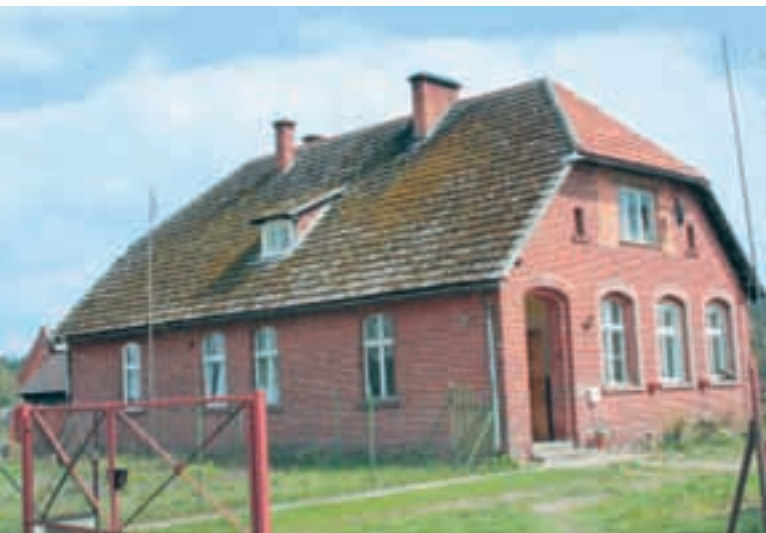
Ryc. 5.98. Gruszcza. Dawna szkoła dziś budynek mieszkalny. Elewacja okaleczona na poddaszu przez wymianę na okna o innych proporcjach.
