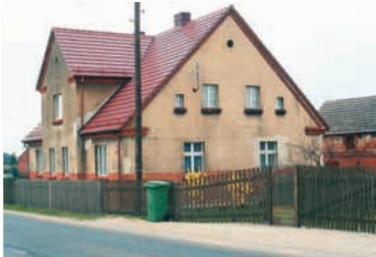
Ryc. 5.6. Czarnogózdzie. Duża lukarna, stanowiąca osiowy ryzalit na ścianie podłużnej budynku. Wysoki, ceglany cokół do poziomu okien parteru.
