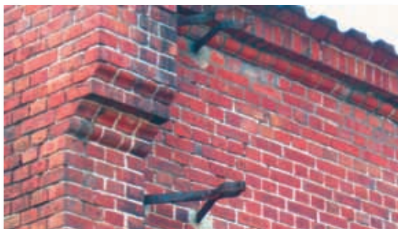
Ryc. 5.35. W budynkach z końca XIX w. możemy spotkać jeszcze bogatszy detal, pojawiają się również kolankowe i esowate profile ceramiczne. Widać zachowane oryginalne mocowania rur spustowych. Taki detal i układy elementów możemy spotkać w ówczesnych pruskich budynkach użyteczności publicznej, np. urzędach, szkołach czy budynkach militarnych.
