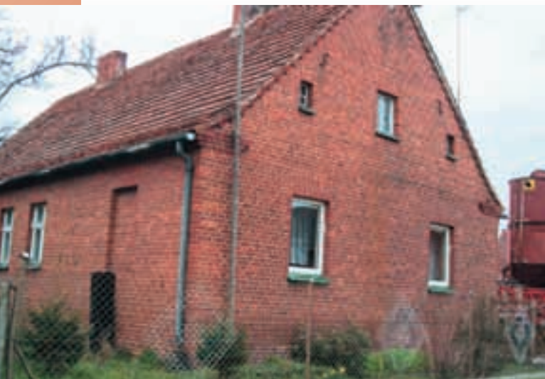
Ryc. 5.15. Żeleźniki. Tu wnęka w elewacji podłużnej zachowuje porządek w jej układzie okien.
