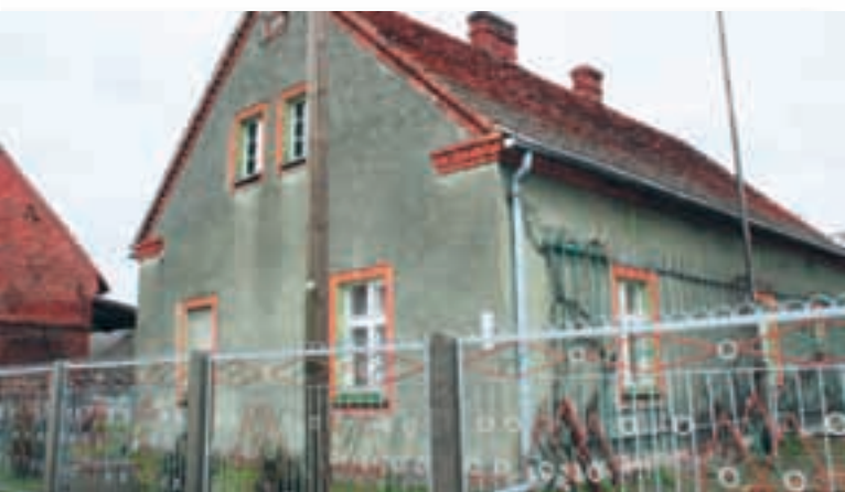
Ryc. 5.22. Żeleźniki. Przykład budynku o tynkowanym licu muru. To drugi po klinkierowym, charakterystyczny typ domu na tym terenie. Opaski okien wyróżniono fazowaniem płaszczyzny i trafnie podkreślono kolorem. Uwagę zwracają charakterystyczne dla okresu międzywojennego szklione, zielone podokienniki ceramiczne.
