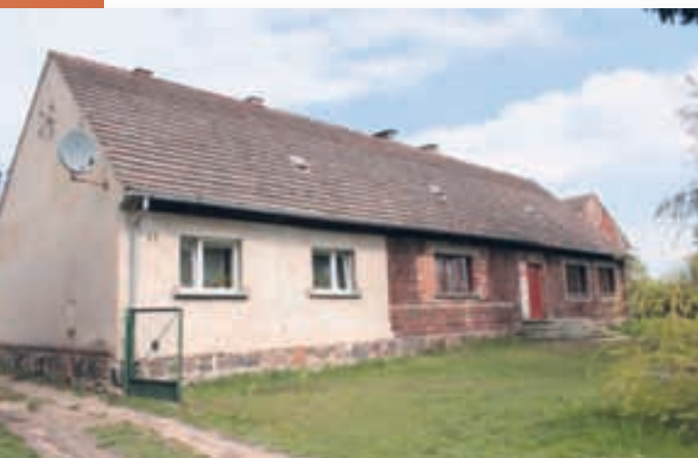
Ryc. 5.114. Pracze. Świetlica wiejska w dawnym domu ludowym. Zmiana proporcji okien, wprowadzenie betonowych nadproży i otynkowanie ceglanej elewacji.
