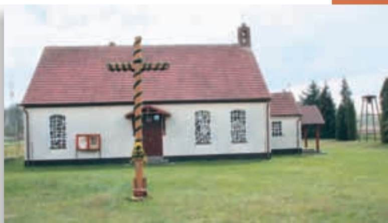
Ryc. 5.101. Godnowa. Dawny budynek szkolny, dziś kaplica p.w. Św. Józefa. Przykład dobrej nowej funkcji w budynku, natomiast złej modernizacji (otynkowanie pierwotnie licowanych cegłą elewacji – charakterystycznego elementu w całej wsi).
