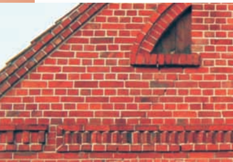
Ryc. 5.31. W tym wypadku zawinięty gzyms zmienia formę, by po małej przerwie jeszcze w innej formie przecinać całą ścianę szczytową. Zwraca uwagę słiczne okienko wentylacyjno-doświetlające niemieszkalne fragmenty poddasza.
