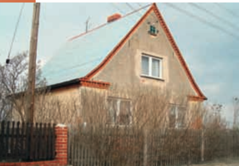
Ryc. 5.4. Stara Huta. Tynkowana elewacja w naturalnym, piaskowym kolorze, widoczne gzymsy z cegły licówki.
