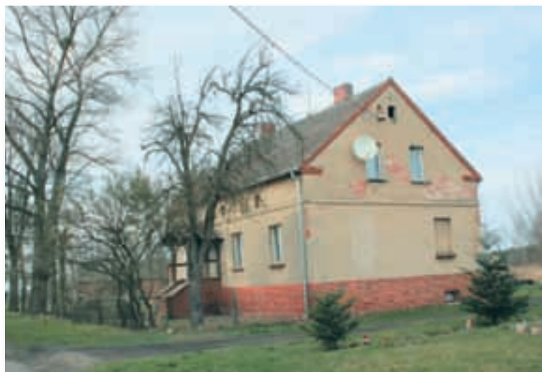
Ryc. 5.7. Henrykowice. Ścianka kolankowa, podkreślona gzymsem pośrednim, zwiększa kubaturę mieszkalnego poddasza ale zmienia przy tym proporcje budynku.
