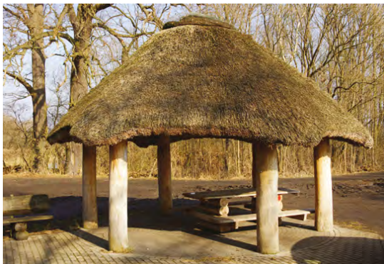
Wiata obok mostu przy Nowym Grodzisku (fot. C. Tajer)
